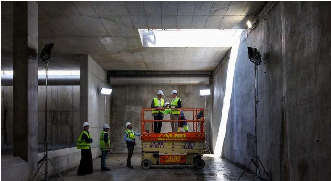
Visita de la Xunta a los trabajos de saneamiento en Pontevedra. Foto: Xunta
