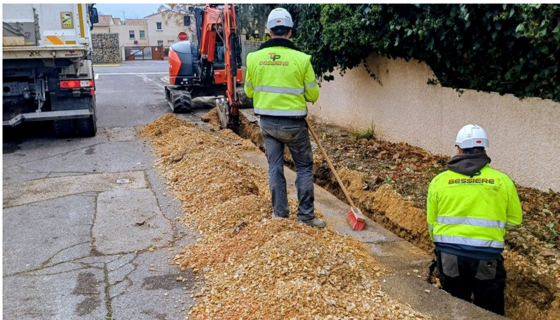
Les nouvelles buses sont en place.
