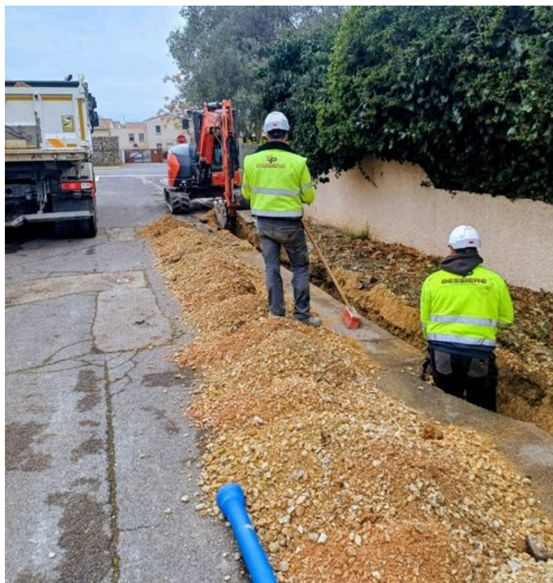
Les nouvelles buses sont en place.
